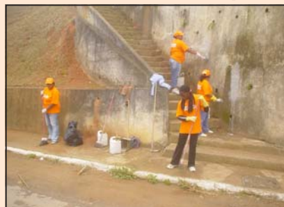
Pintura de meios-fios
