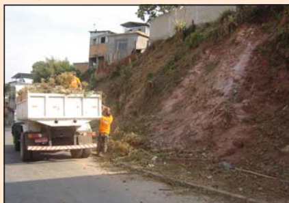
Retirada de entulhos
