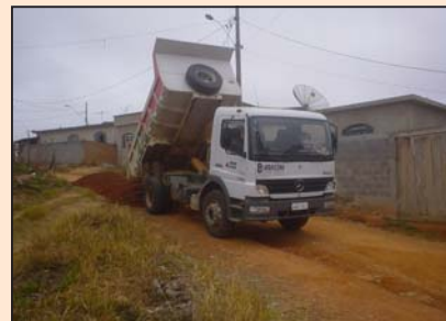
Encascalhamento de ruas
