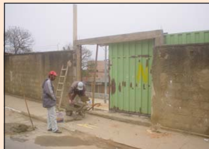
Reforma do portão da quadra da Escola Municipal Alberto Vieira
