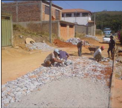
Finalização do calçamento da rua João Marinho, no bairro Floresta.
