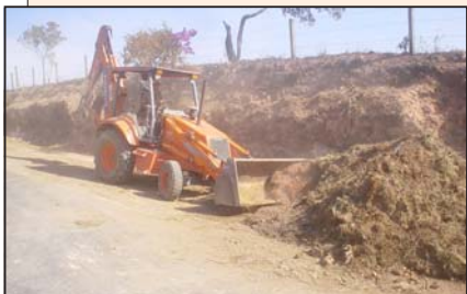
Retirada de entulho da Rua Bertolim, no bairro Eucisa. O local também recebeu trabalhos de capina.
