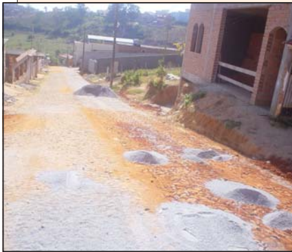
Calçamento da rua Pedro Rogério de Araújo, no bairro São Cristóvão
