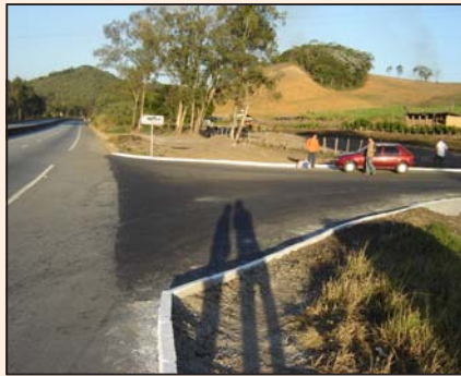
Trevo já asfaltado
