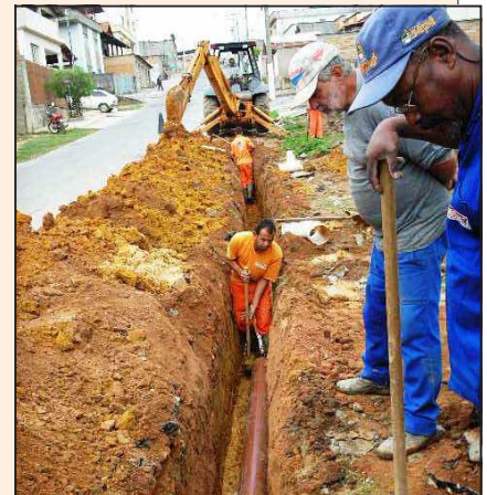
Construção da rede de esgoto na rua Honório Armond, no bairro Monsenhor Mário Quintão
