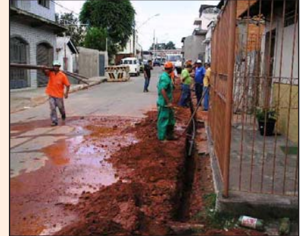
Substituição da rede de abastecimento de água da rua Dalmo Apolinário, no bairro Grogotó. Com este trabalho o abastecimento de água volta ao normal
