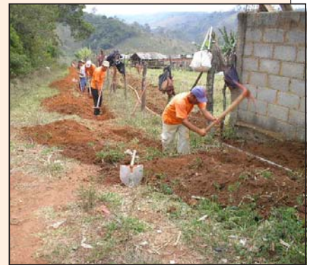
Rebaixamento da rede de abastecimento de água, no distrito de Correia de Almeida
