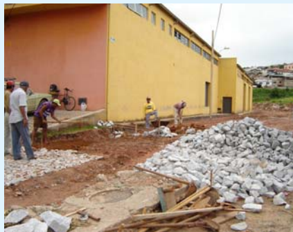
Calçamento da rua João Batista Loschi, no bairro São Pedro
