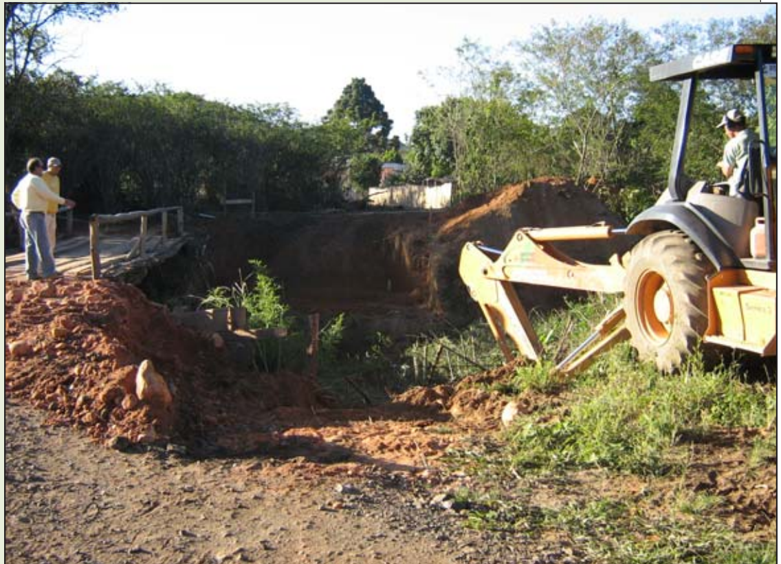
Construção da ponte do Jacob
