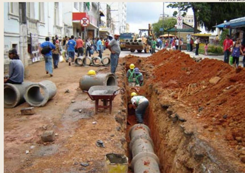
A nova rede de captação de água está sendo feita antes da colocação do piso
