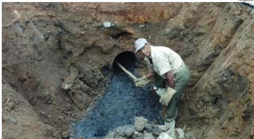
Patrulha da Água desentope esgoto e rede pluvial no Caiçaras
