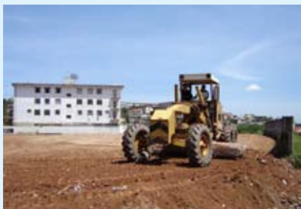
As obras para a construção da nova praça foram iniciadas na última semana
