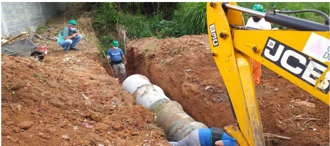
FOTO 03 | Assentamento dos tubos de concreto
