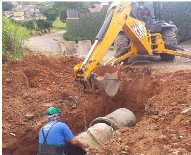
FOTO 02 | Assentamento dos tubos de concreto
