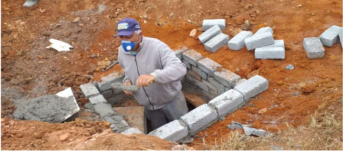
FOTO 04 | Construção de caixa
