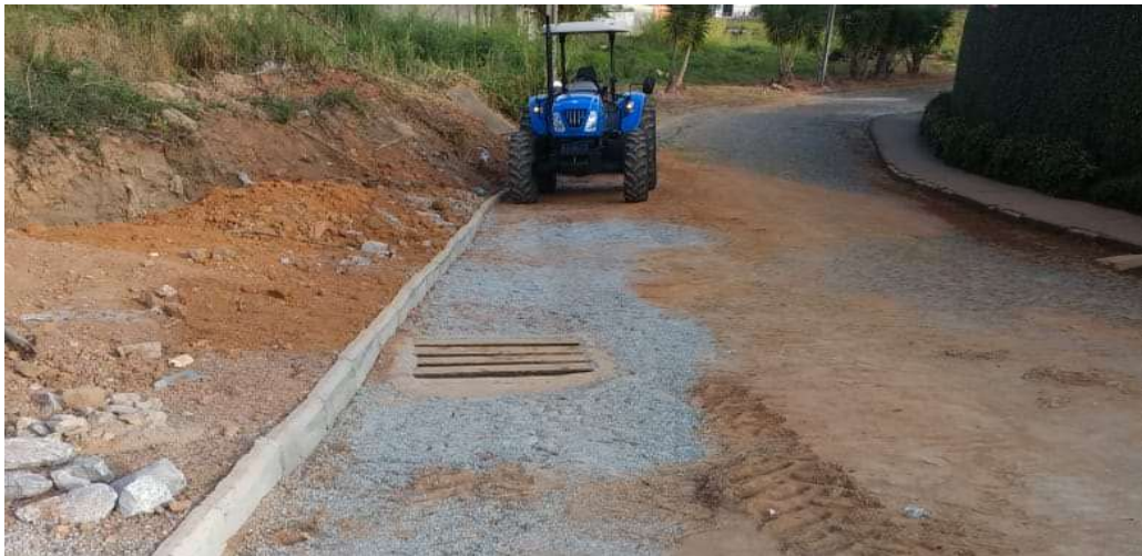
FOTO 05 | Compactação do pavimento
