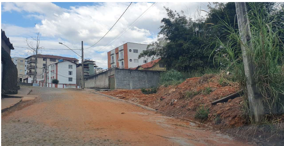
FOTO 06 | Finalização da obra
