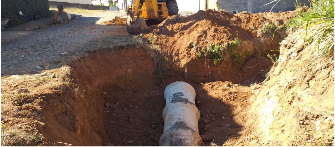
FOTO 01 | Assentamento dos tubos de concreto
