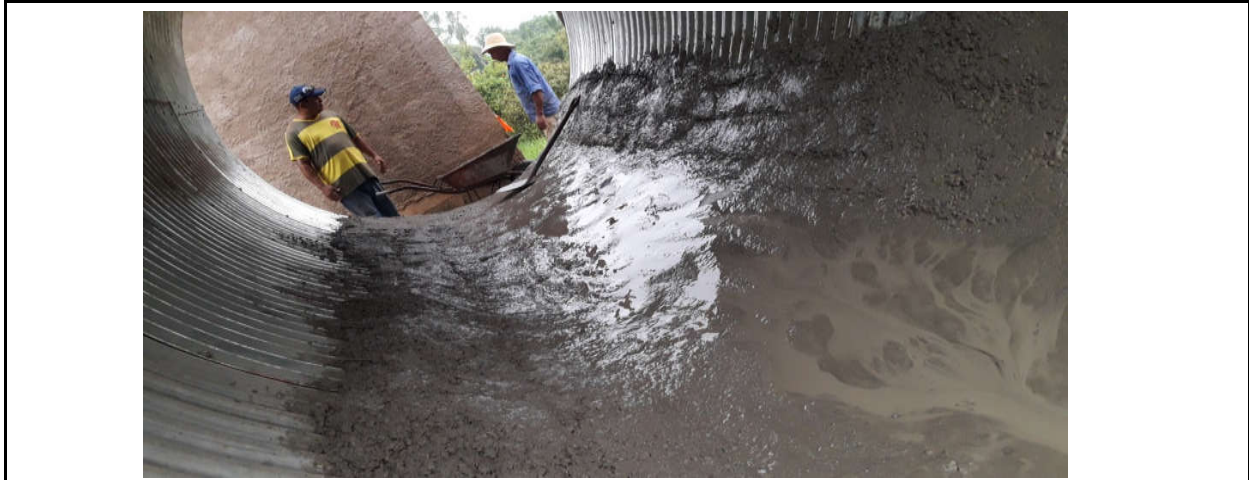
FOTO 04 Concretagem do tubulão conforme orientação da SETOP
