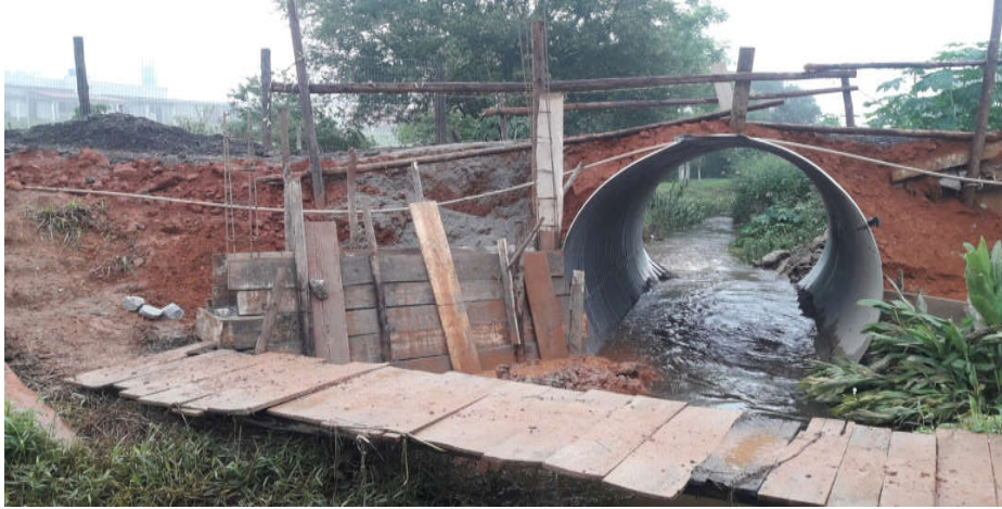
FOTO 07 | Execução de forma e concretagem da alas laterais
