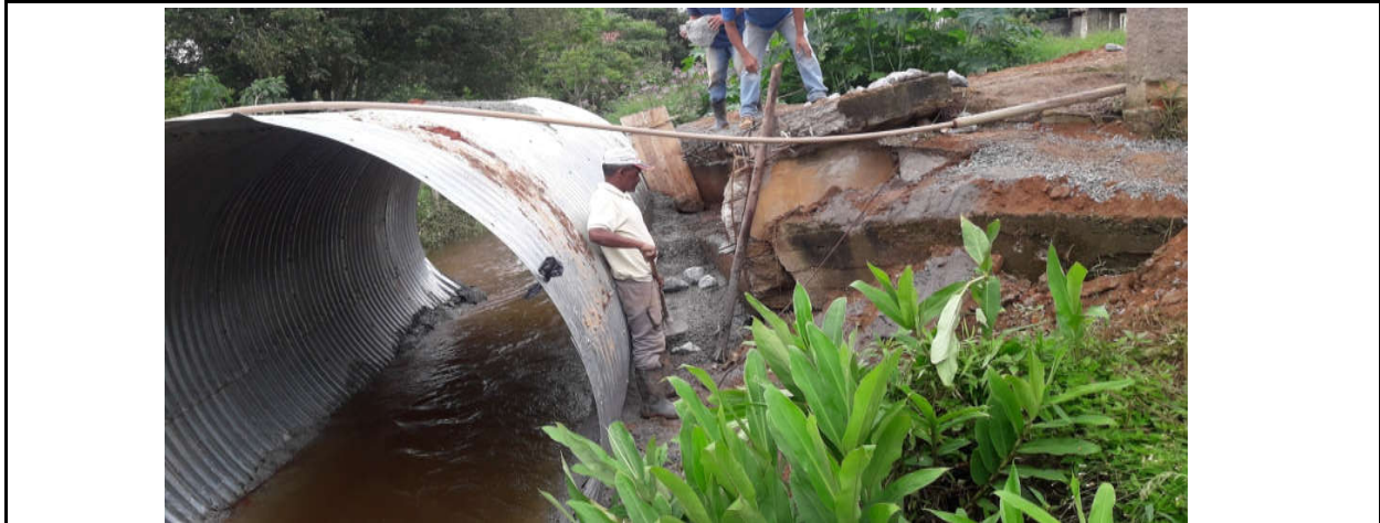
FOTO 06 Início do travamento do Bueiro Armco no local
