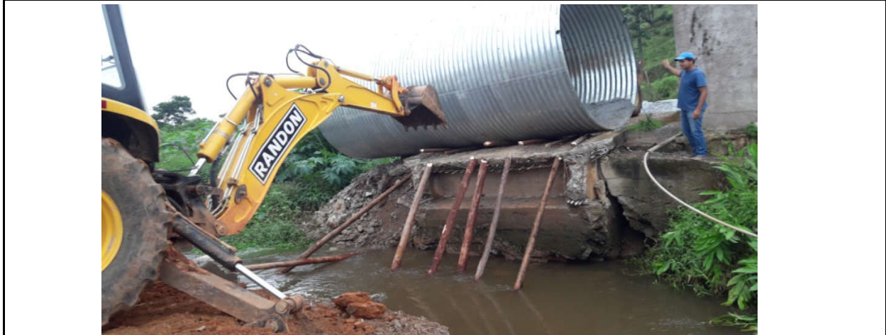
FOTO 05 Colocação do Bueiro Armco no canal
