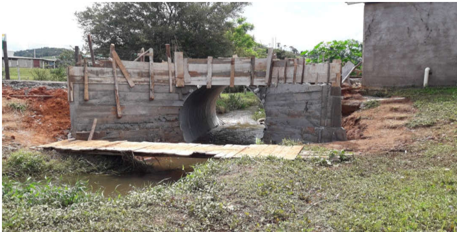
FOTO 08 | Execução de forma e concretagem da alas laterais
