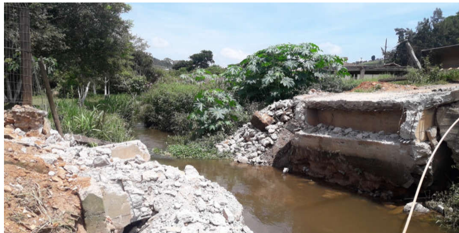
FOTO 03 Ponte existente demolida
