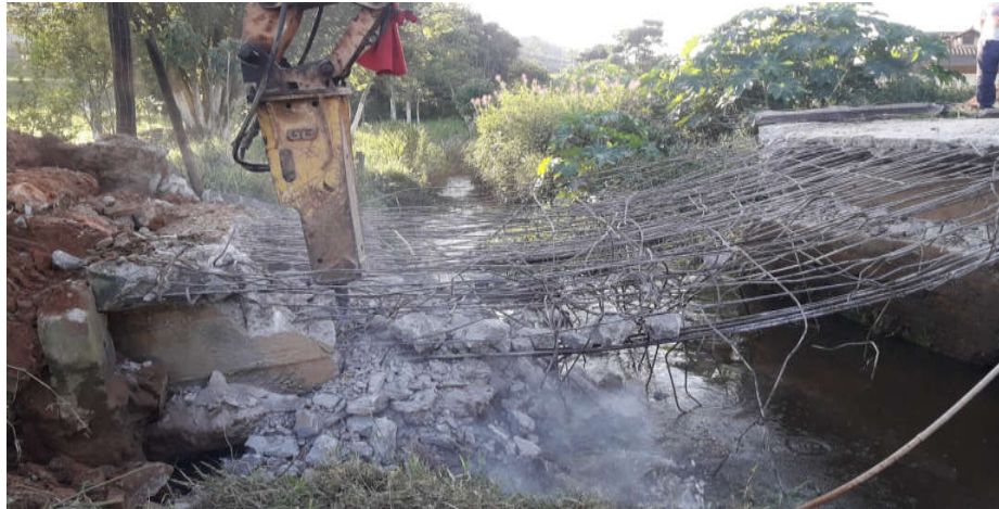
FOTO 02 Demolição da ponte danificada
