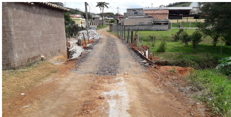
FOTO 09 | Finalização da pista
