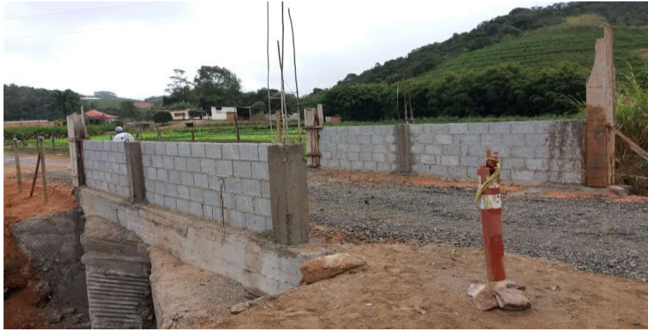
FOTO 10 | Construção do guarda corpo
