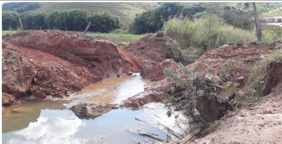
FOTO 03 Ponte existente demolida
