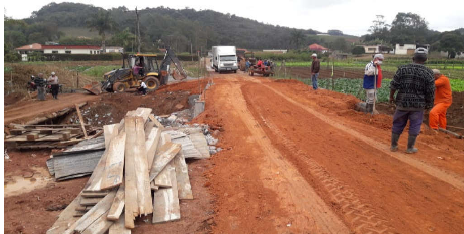
FOTO 09 | Finalização da pista
