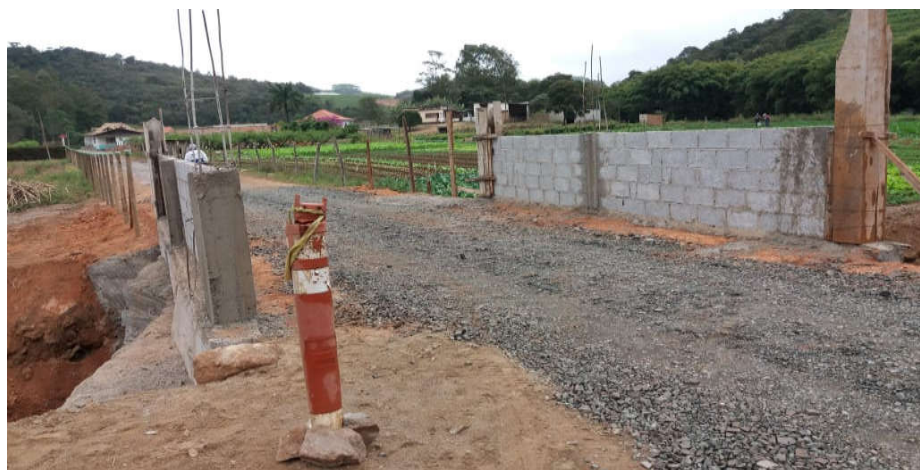
FOTO 12 | Construção do guarda corpo
