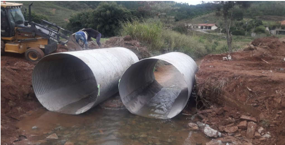
FOTO 05 Colocação dos Bueiro Armco no canal
