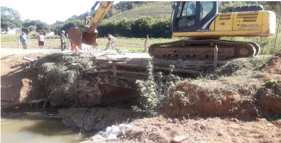
FOTO 02 Demolição da ponte danificada
