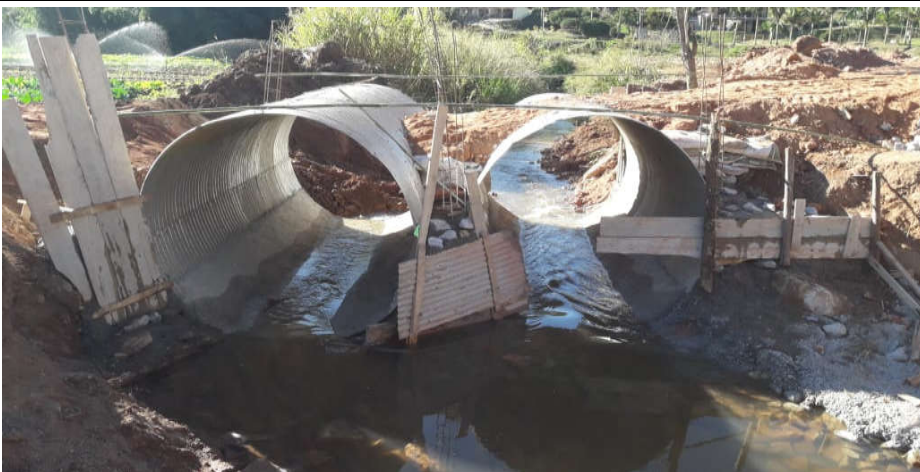
FOTO 06 Início do travamento do Bueiro Armco no local
