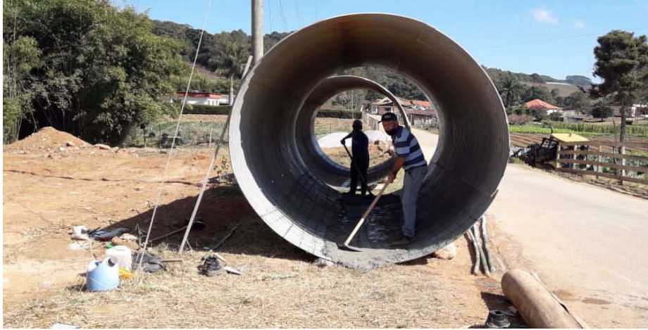
FOTO 04 Concretagem do tubulão conforme orientação da SETOP
