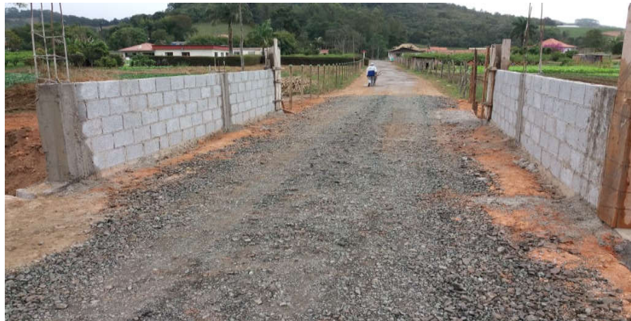
FOTO 11 | Construção do guarda corpo
